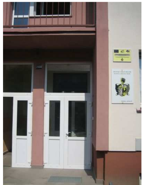
Vchod do sociální ubytovny
